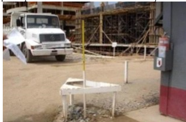
c) Caixa de proteção de Bench-Mark.
