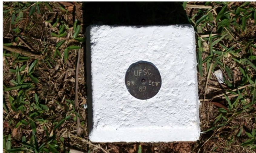
Figura 34: Exemplo de Marco de Concreto do Ponto Topográfico ECV69 UFSC. Fonte: Zimmermann (2019).
